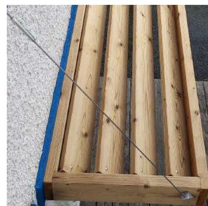
Vue de détail fixation tirant inox sur façade
