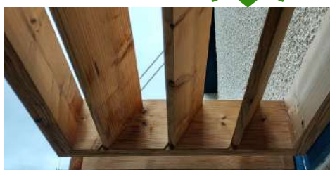
Vue de détail des fixation des lames
